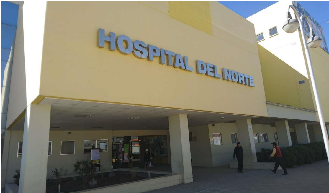
Fuente: Área de Comunicación Hospital del Norte.
