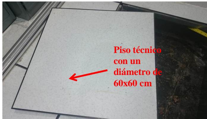
Figura 2.14 Suelo técnico Air Driving Floor
