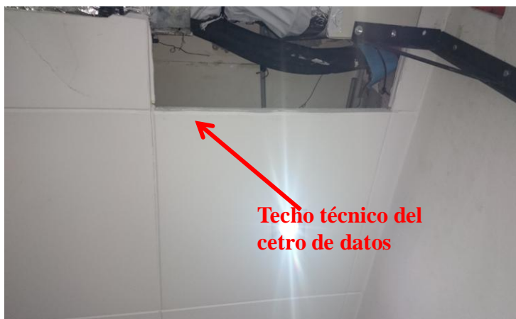
Figura 2. 18 Techo Técnico implementado
