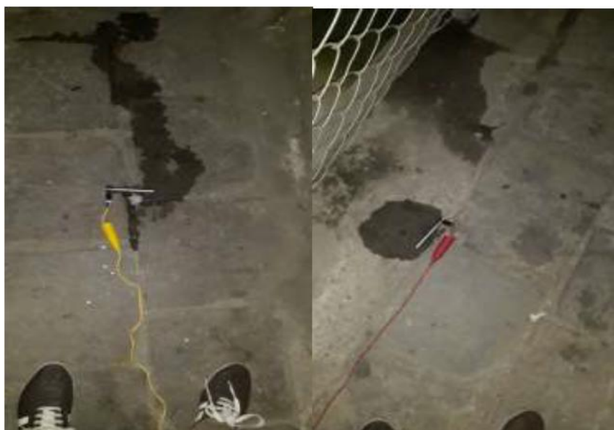
Figura 2. 67 Medición de las puestas a tierra
