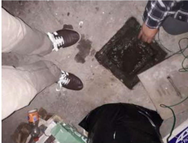
Figura 2. 68 Medición de puesta a tierra de protección eléctrica externa
