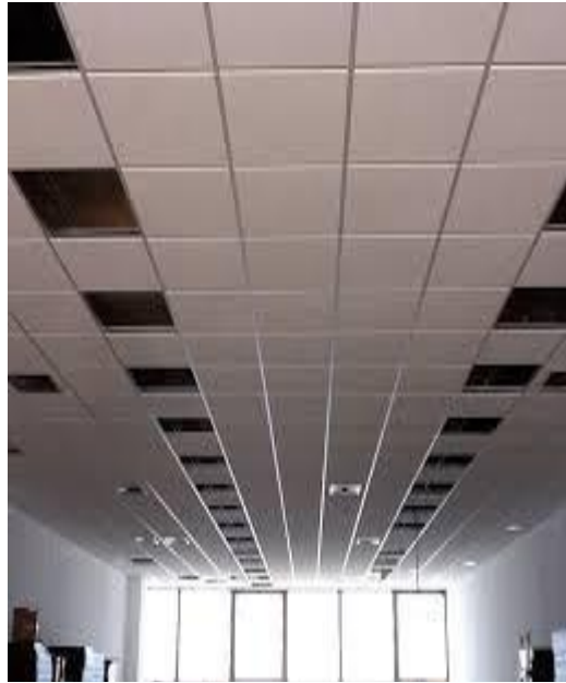
Acabado del pasillo del CPD
