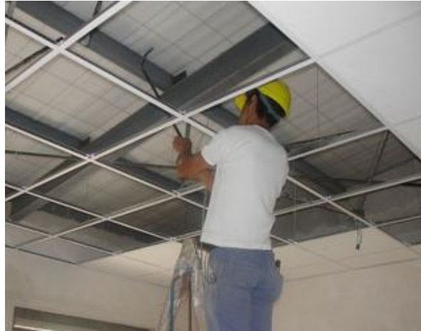
Figura 2.16 Instalación del Techo Técnico
