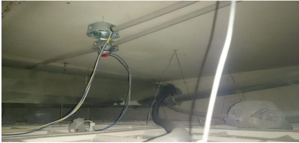
Armado del techo técnico el en CPD
