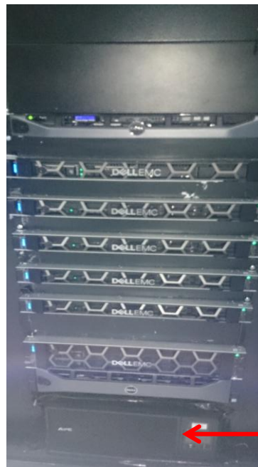
Figura 2. 59 Sistema de Energía Ininterrumpida instalado en la Rack
