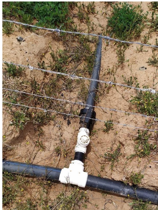
Figura 5. Instalación del lateral principal
