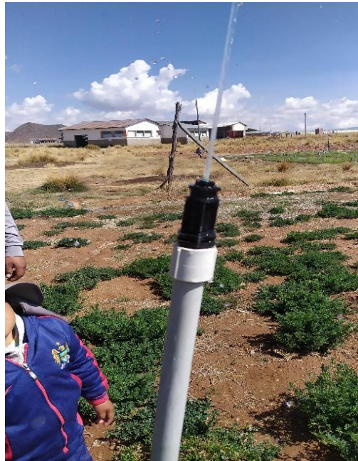
Figura 6. Instalación de posta-aspersores
