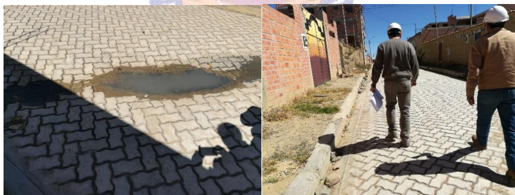
Fotografía 4: Inspección de proyecto enlosetado
