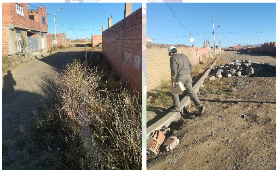
Fotografía 5: Inspección proyecto cordones de acera
