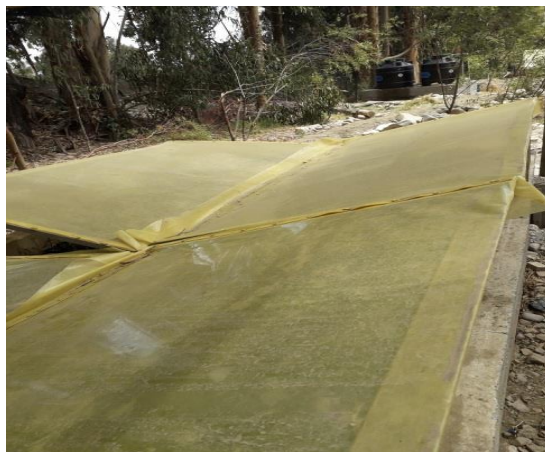
Fotografía 2. Establecimiento del micro túnel
