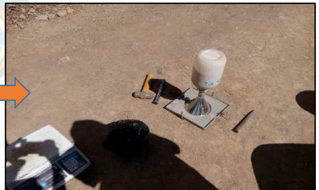
VERIFICACION DEL GRADO DE COMPACTACION
