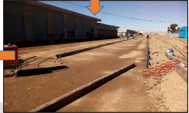
COLOCADO DE LAS FORMALETAS
