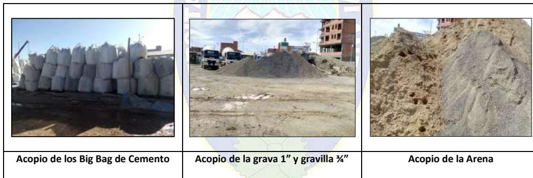
Ilustración 18 ACOPIO DEL CEMENTO Y AGREGADOS
