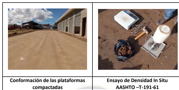
Ilustración 17 ENSAYO DE DENSIDAD IN SITU PARA VER EL GRADO DE COMPACTACION
