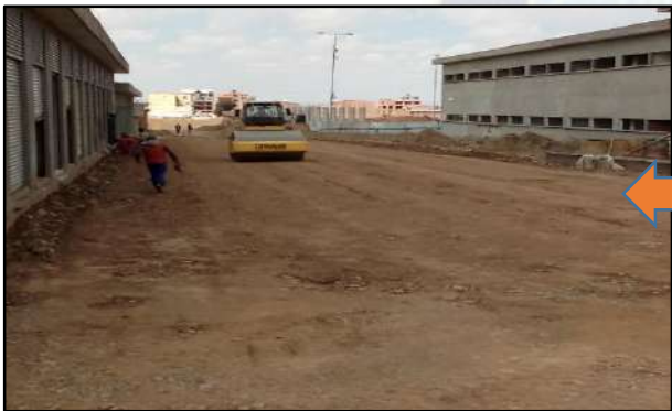
COMPACTACION DEL TERRAPLEN
