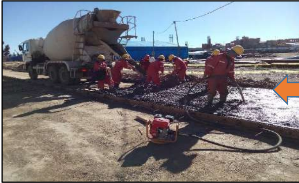
VACIADO DE LA LOSA DE HORMIGON HF - 45
