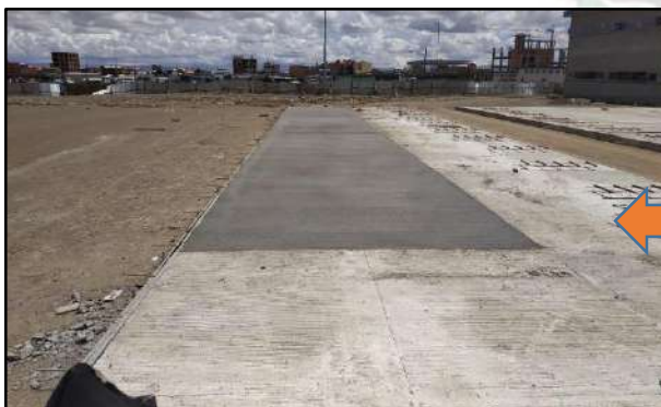
PAVIMENTO RIGIDO TERMINADO
