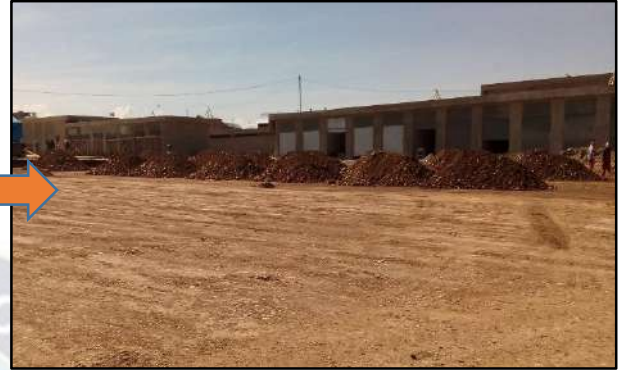
ACAMELLONAMIENTO DEL MATERIAL PARA TERRAPLEN
