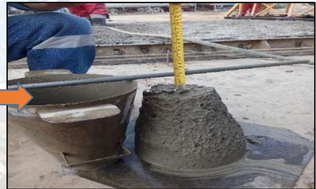
CONTROL DE LA CONSISTENCIA DEL HORMIGON
