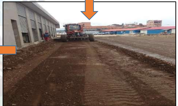
BATIDO Y PERFILADO DEL MATERIAL CON MOTONIVELADORA
