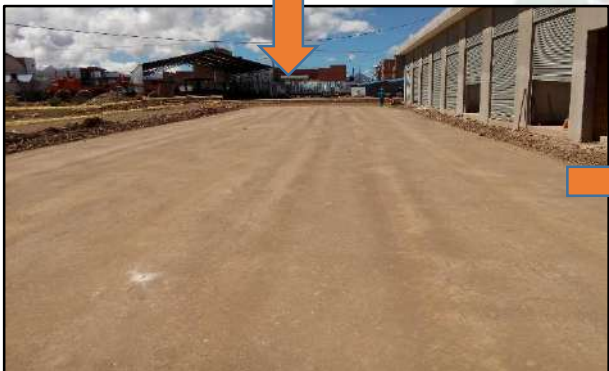
CAPA SUB BASE TERMINADA
