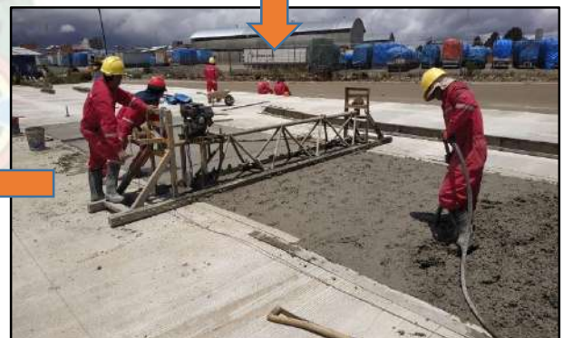
NIVELADO CON REGLA VIBRATORIA
