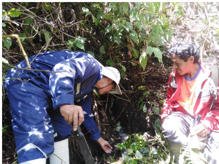
Limpieza de Terreno
