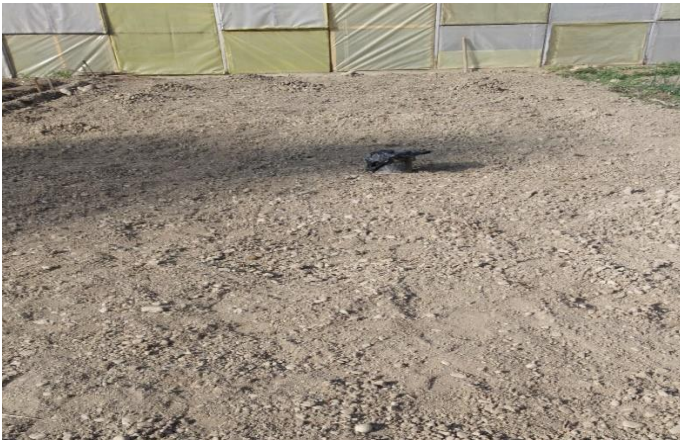
Figura 9. Preparación del terreno
