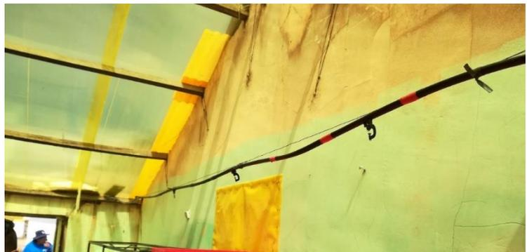
**FIGURA 7 y 8. Micro aspersores instalados dentro del ambiente atemperado.**
