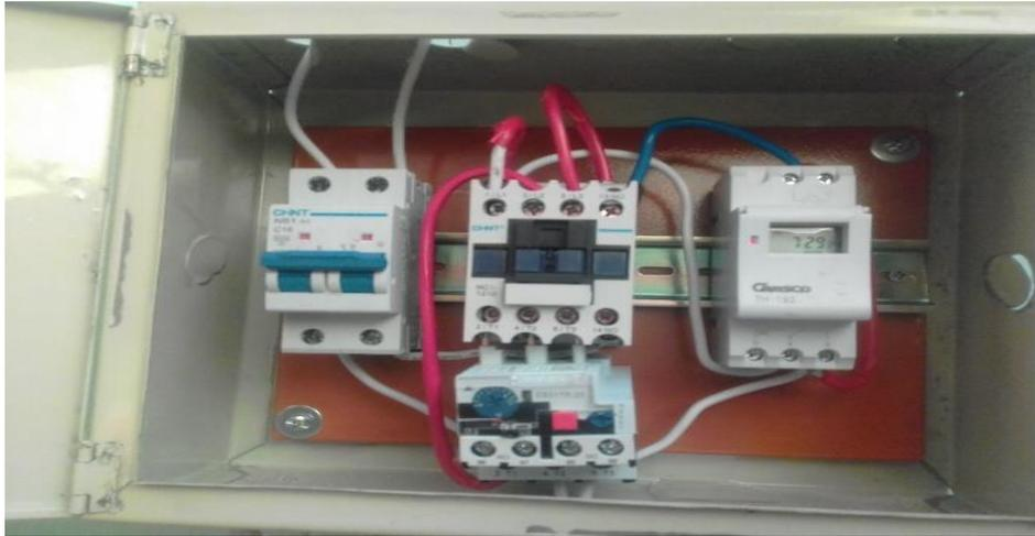
**FIGURA 9. Timer instalado, dentro del ambiente atemperado**
