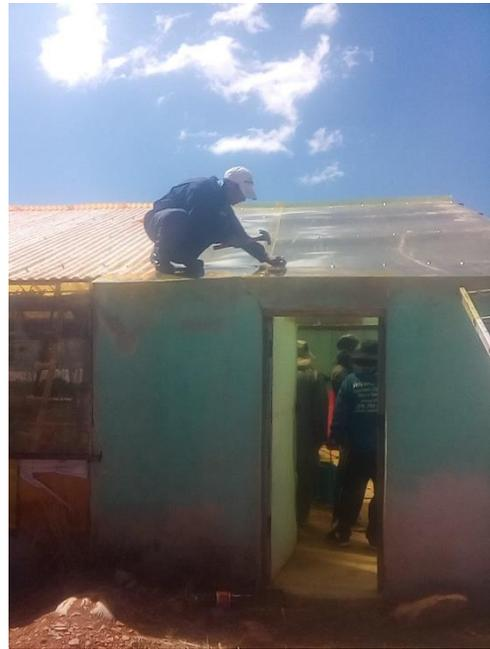
**FIGURA 2. Destejado del ambiente atemperado. FIGURA 3 Colocado de policarbonato**
