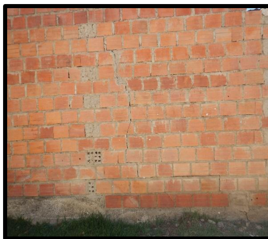
Figura 3.3. Grieta vertical 1.5 cm de rechazo vertical.
