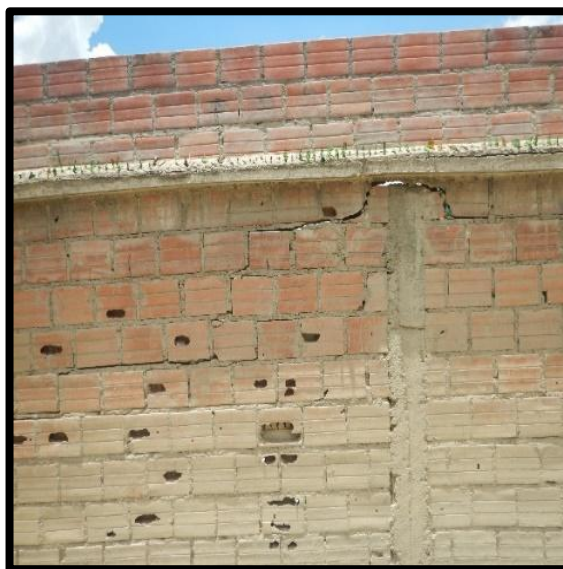
Figura 3.16. Grieta horizontal con separación de 2 cm.
