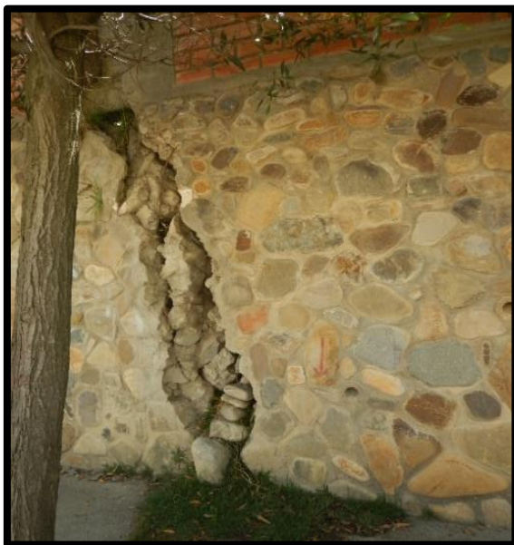
Figura 3.6. Grieta vertical rechazo 18 cm.
