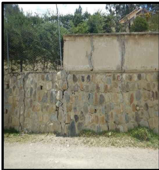
Figura 3.13. Grietas en muro perimetral Carmelitas
