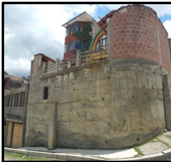
Figura 3.19. Muro de contención con presencia de grietas
