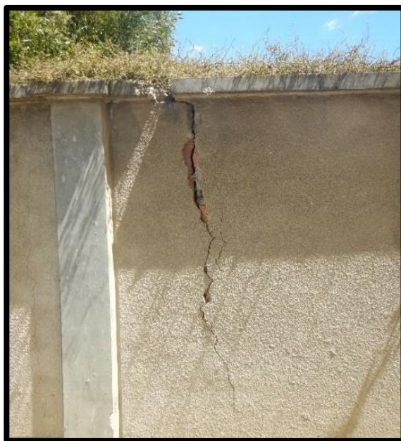
Figura 3.21. Muro perimetral Edif. Roma Grieta vertical
