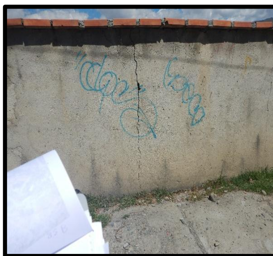
Figura 3.4. Grieta vertical 4 cm de rechazo vertical.
