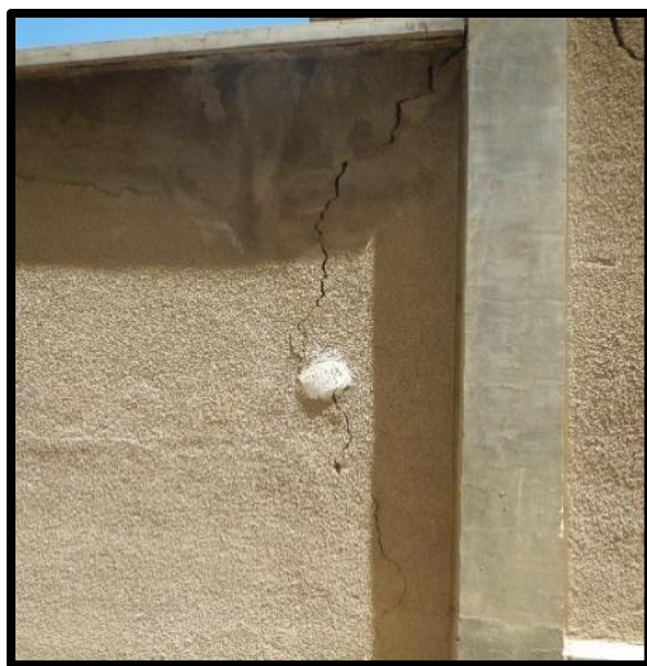
Figura 3.23. Grieta oblicua con testigo Edif. Roma
