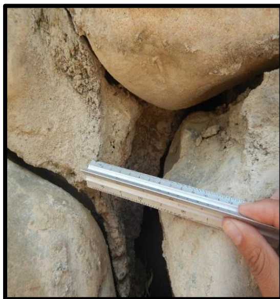
Figura 3.14. Grieta muro perimetral con rechazo de 6 cm.
