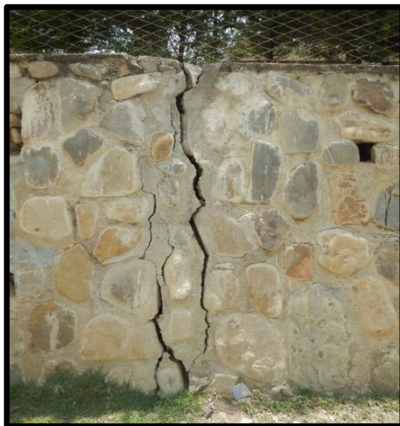
Figura 3.15. Grieta vertical con separación de 4.5 cm.
