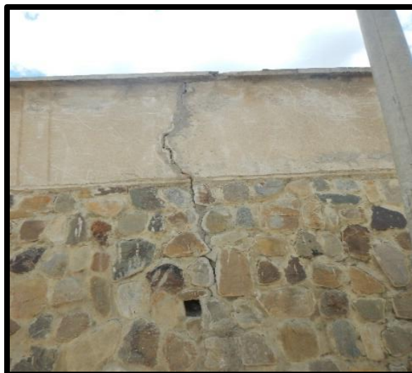
Figura 3.17. Grieta oblicua con nueva separacion.
