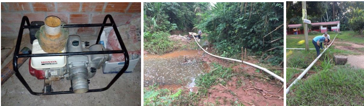
Figura 24: Instalación de tuberías y motobomba para el bombeo de agua.
