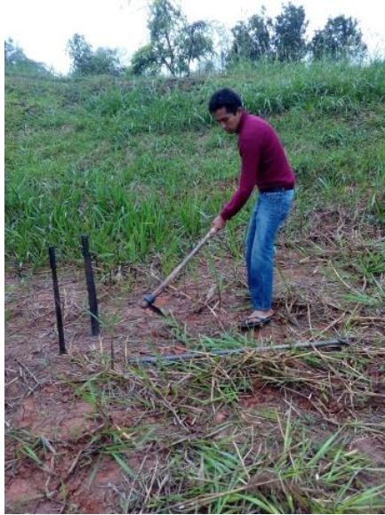
Figura 17: Deshierbe del estanque y los taludes
