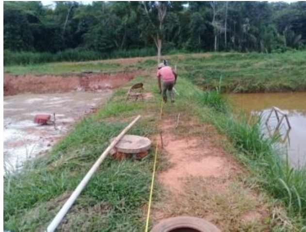
Figura 21: Medición del estanque para realizar las separaciones
