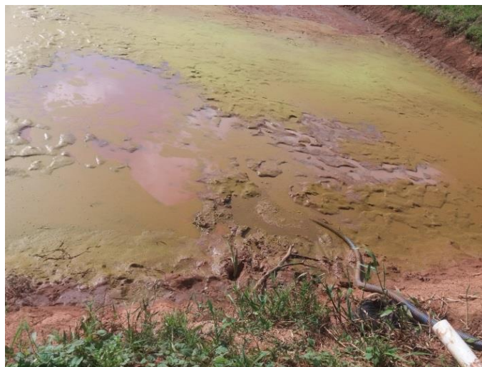
Figura 18: Presencia de lodo y materia orgánica en descomposición
