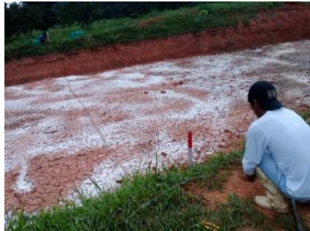
Figura 22: Tesado de alambre galvanizado para las separaciones
