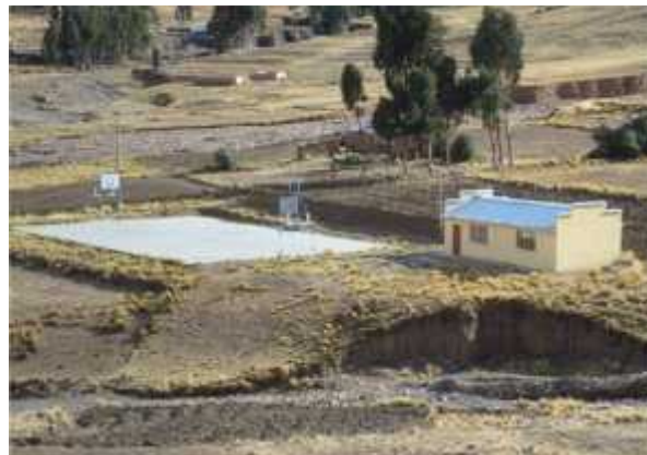
Fotografía 4. Sede Social y Cancha Polifuncional de la Comunidad Chuñuña Norte - Pacoma
