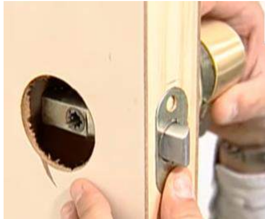
Figura 11: Instalación de la chapa
