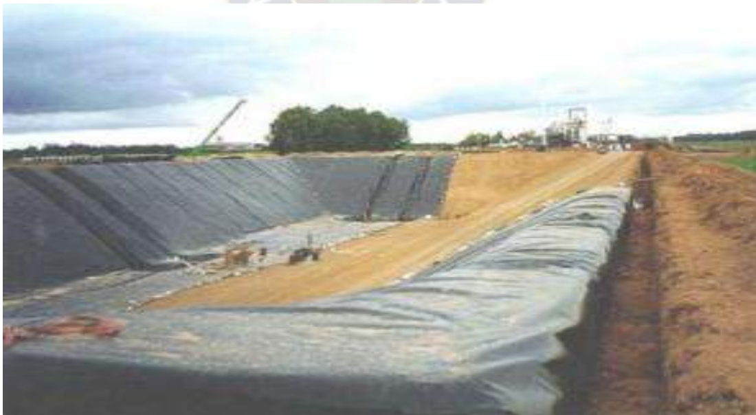
FIGURA 4-5 RELLENO DE TRINCHERA
