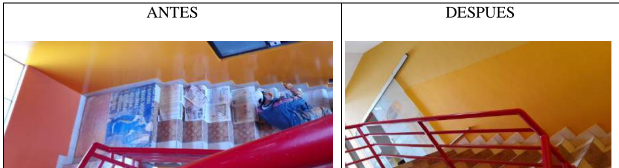
Ilustración 6.5. BARANDAS DE SEGURIDAD
