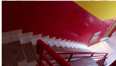
Ilustración 4.9: INFRAESTRUCTURA DE ESCALERAS
