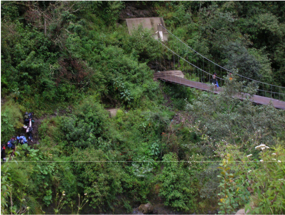
PUENTE COLGANTE CAMINO DEL INCA (EL CHORO)
