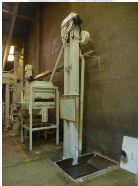
FIGURA 5-63. Cangilón transportador de granos en escarificado en la empresa Irupana S.A.
