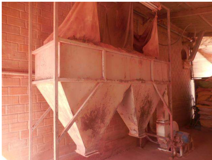
FIGURA 6-3. Ciclones recolectores de material particulado implementados en Irupana S.A.
