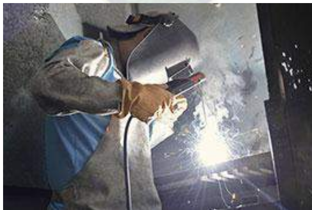
FIGURA 5-62. Trabajos de soldadura con los implementos necesarios en la empresa Irupana S.A.
