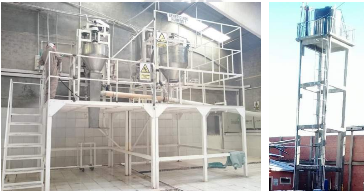
FIGURA 5-20. Trabajos en alturas mayores a 1,8 metros en la empresa Irupana S.A.
