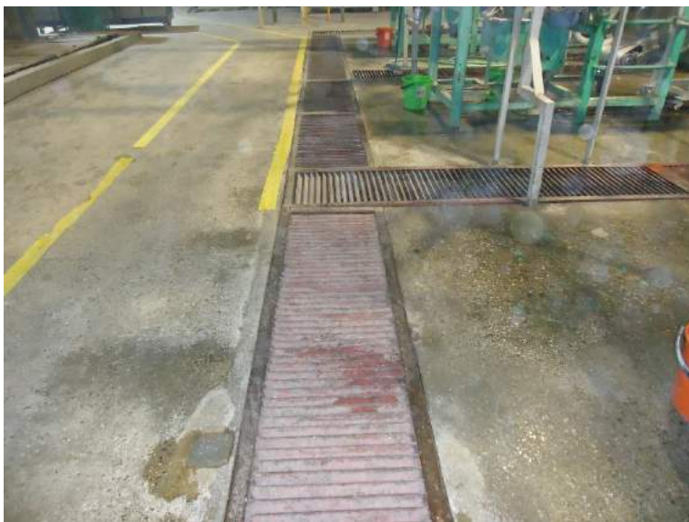
FIGURA 5-21. Drenajes y suelo mojado en las áreas de trabajo de Irupana S.A.
