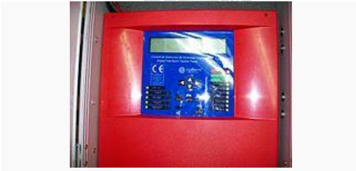
Figura 14 - Central Direccional de 2 bucles COFEM con certificado EN 54-2 y EN 54-4.
