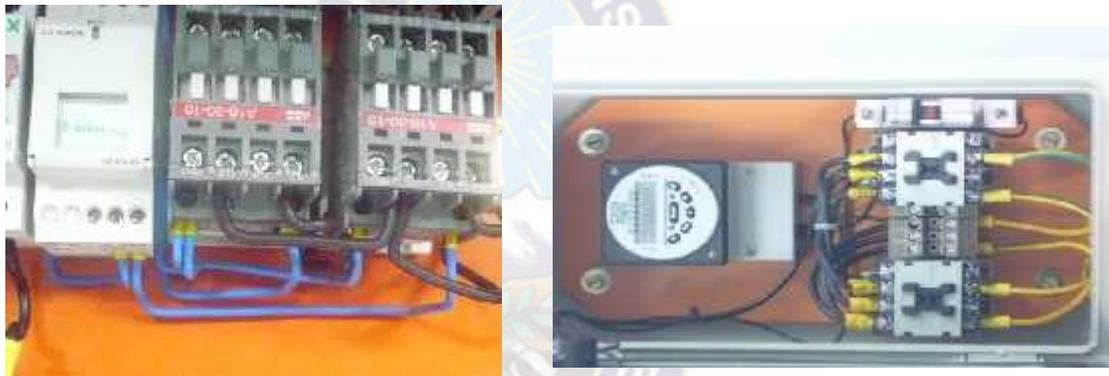
*Figura 3.3 Temporizador con sus respectivos contactores*
