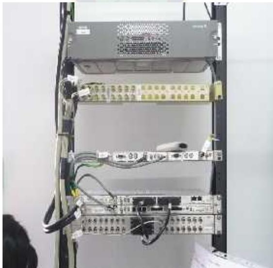
Figura 3.69 Radio Minilink y NEC en un solo Rack
