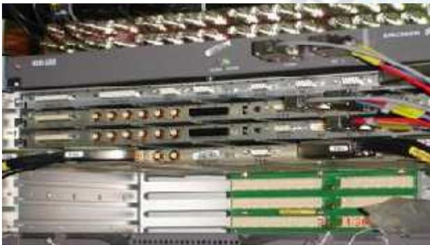
Figura 3.59 Disposición de las tarjetas en la unidad AMM 4-U
