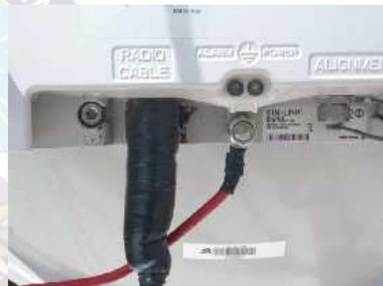
Figura 3.71 Aumento de cable de tierra al RAU, después del mantenimiento
