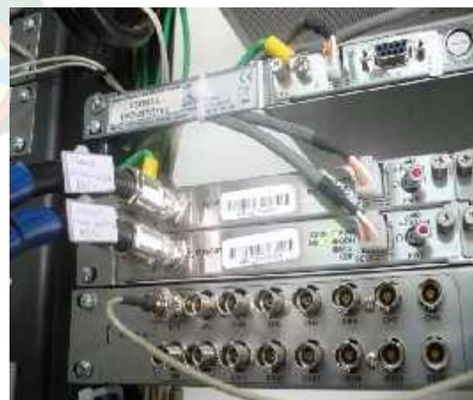
Figura 3.66 Cable IF par el NEC
