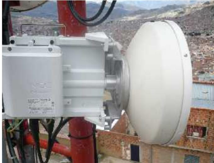
*Figura 3.67 Antena y ODU en Configuración 1+1 Passolink Neo*
