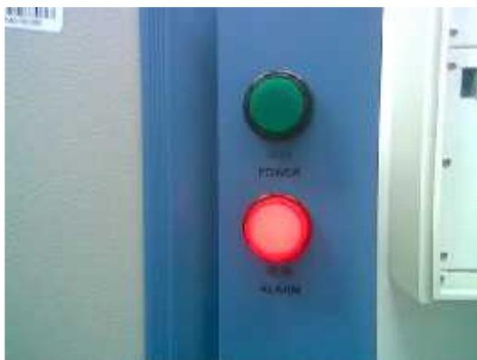
*Figura 3.86 Rectificador PS48300/1800 Alarmado*
