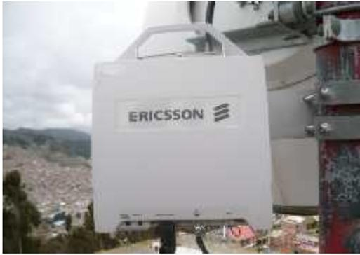
*Figura 3.56 ODU (RAU) del Radio Minilink*
