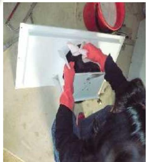
Figura 3.54 Limpieza del Extractor de la BTS 3012A
