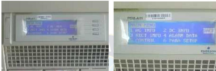
*Figura 3.28 Vista del Módulo de Monitoreo PSM-A11*
