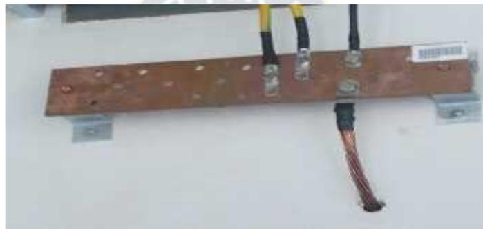
Figura 3.11 Barra de cobre LGB
