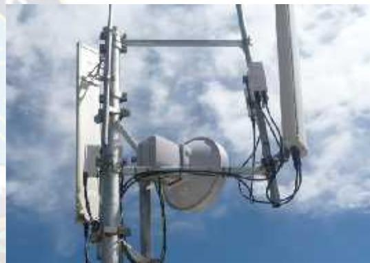
Figura 3.60 Unidades RAU con Configuración 1+1 Minilink
