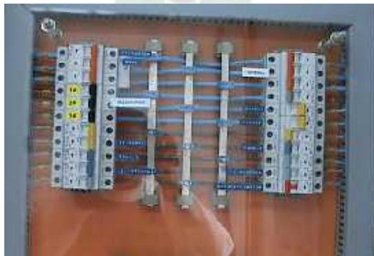
*Figura 3.2 Etiquetado del Tablero de Distribución*
