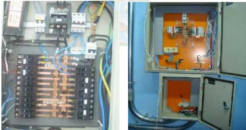
*Figura 3.1 Tableros de Distribución de Energía AC*
