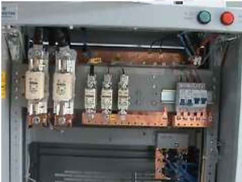
*Figura 3.33 Fusibles del Rectificador
