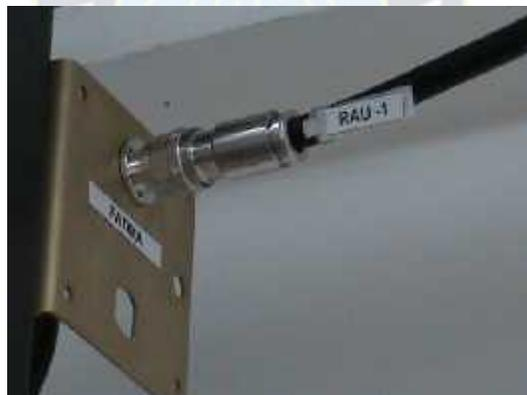
*Figura 3.58 Cable IF que conecta ODU con IDU*
