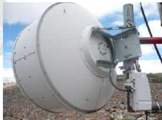
Figura 3.62 Unidad RAU con configuración 1+0
