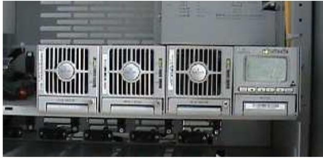
*Figura 3.35 Módulos de Rectificación R48-1800A*
