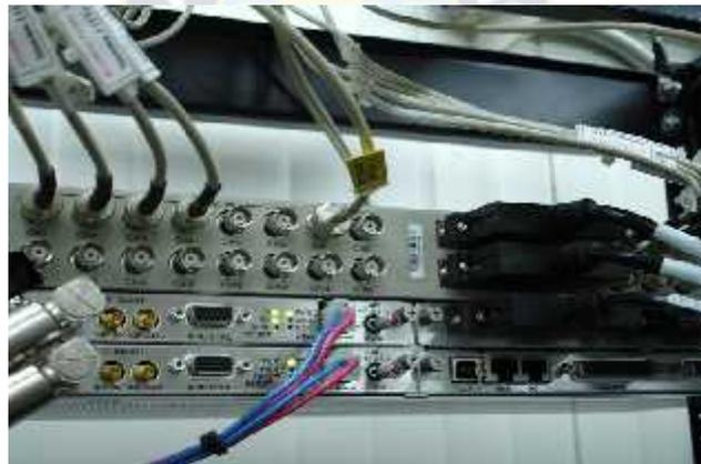
Figura 3.64 Disposición de tarjetas en la IDU NEC
