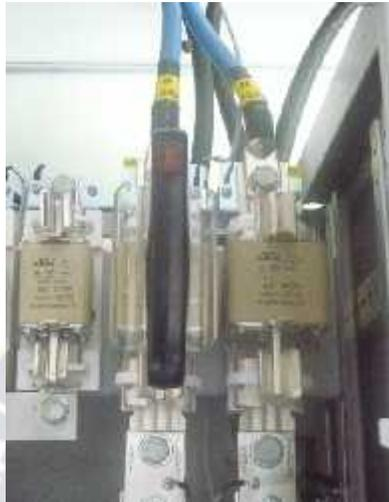
*Figura 3.16 Conexión del Banco al Rectificador*
