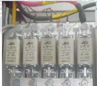
*Figura 3.25 Fusibles del Rectificador PS24600/75*
