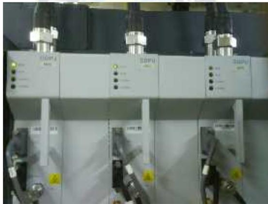
*Figura 3.49 Vista de las tarjetas DDPU de la BTS 3012*
