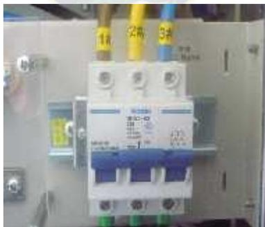
*Figura 3.23 Entrada de las Fases al rectificador*
