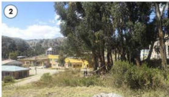
Fig. 67. Fotografías del sitio de intervención Fuente: Propia
