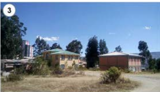
Fig. 69. Fotografías del sitio de intervención Fuente: Propia
