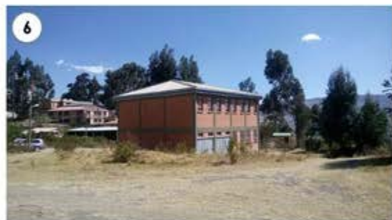
Fig. 70. Fotografías del sitio de intervención Fuente: Propia
