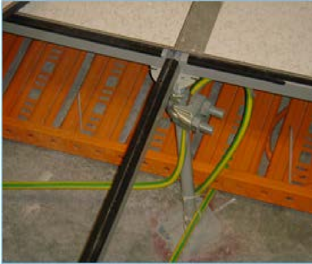
Fig. 4.05 Instalación de tierra en los pedestales
