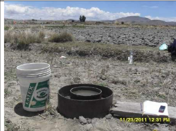
Prueba de infiltración del agua
