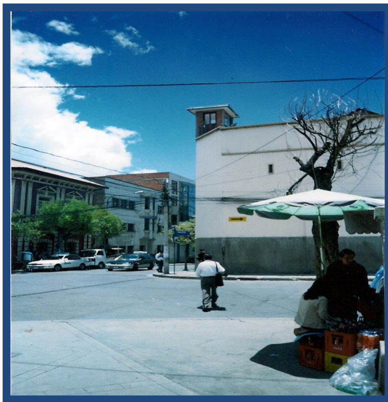
PENITENCIARIA DE “SAN PEDRO” TORRE OPTICA DE GUARDIA – SECTOR UBICADO ENTRE LA CALLE CAÑADA STRONGHEST Y NICOLAS ACOSTA (PLAZA DE SAN PEDRO) – CIUDAD DE LA PAZ
