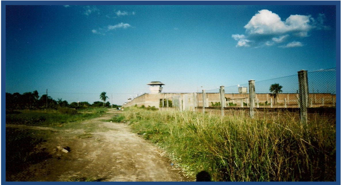
PENITENCIARIA “PALMASOLA” DE SANTA CRUZ – TORRE DE CONTROL
