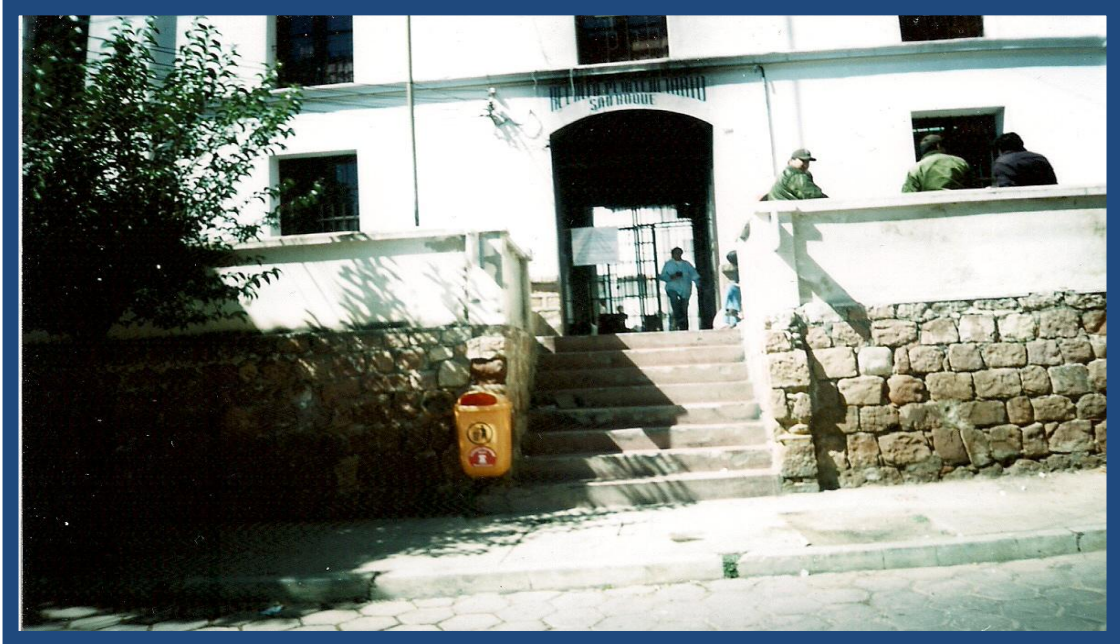
ENTRADA PRINCIPAL DE LA PENITENCIARIA "SAN ROQUE" - SUCRE
