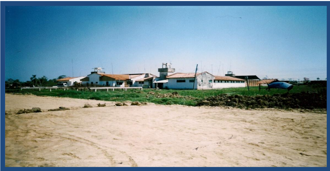
VISTA PANORAMICA DE LA CARCEL "MOCOVI" – TRINIDAD - BENI
