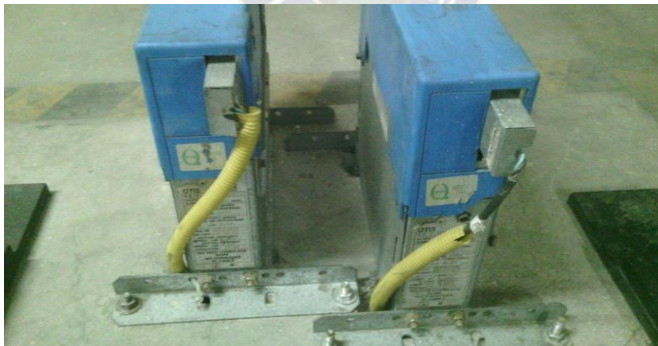
Figura 11.- Limitador de Velocidad
