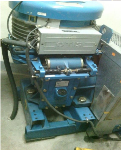
Fotografía 10.- Motor Eléctrico del Elevador
