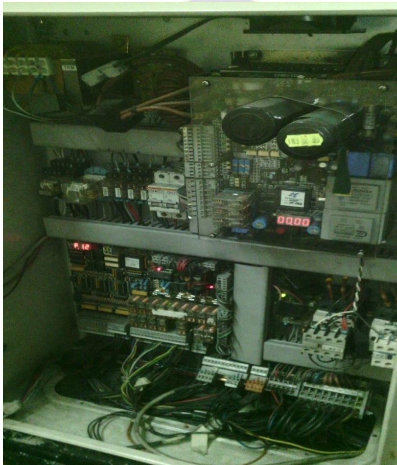
Figura 16.- Tablero de Control
