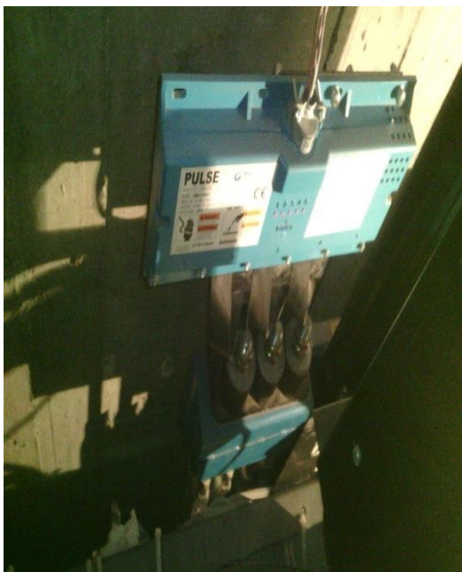
Fotografía 12.- Monitoreo de Cintas De tracción
