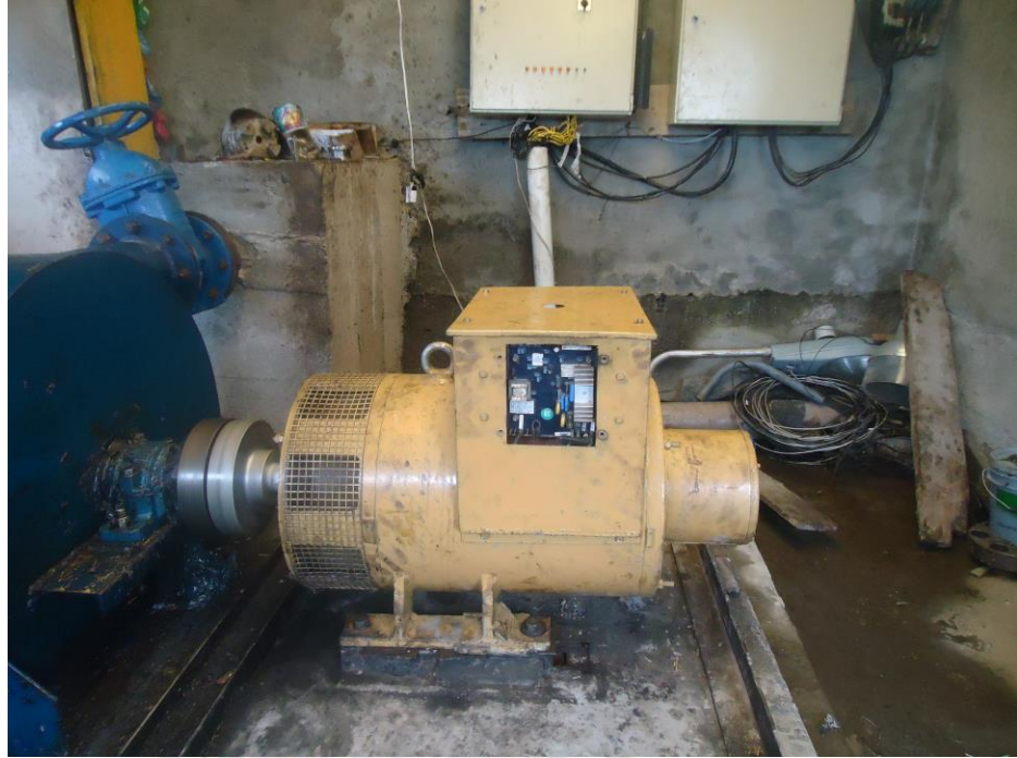
Foto: Casa de maquinas (Agua Blanca)
