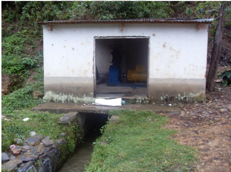
Foto: Casa de Maquinas (Santa Rosa de Quilo Quilo)
