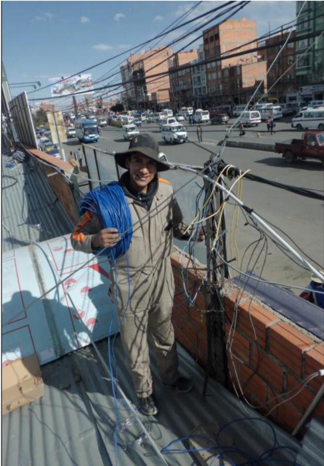
**Fotografía 1** cableado para la red de cámaras del centro comercial el CEIBO
