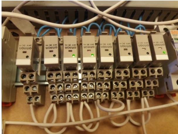
**Figura 4:** Relés de protección para el PLC
