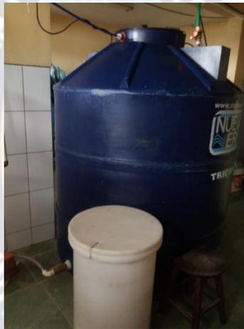
**Figura 8:** Depósito de agua de 2500 litros (agua tratada)
