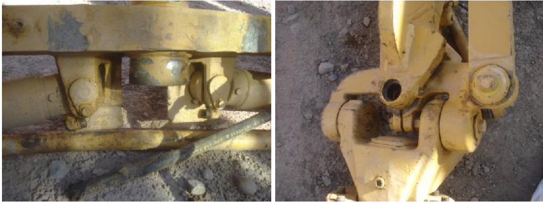
Cilindros de dirección contaminados y con fugas de aceite, vástagos flectados. Articulación de dirección presenta pasadores rotos.
