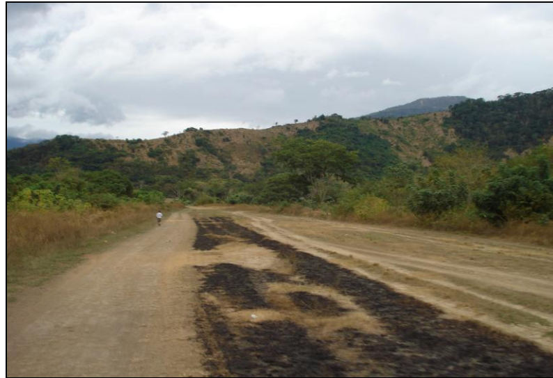
Figura 2.7 Estado actual de la pista de aterrizaje
