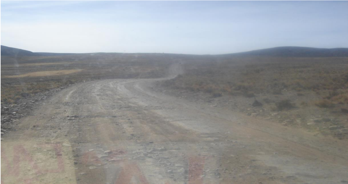
Fig. .6: Caminos en mal estado.
