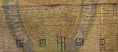
Detalle de fachada
