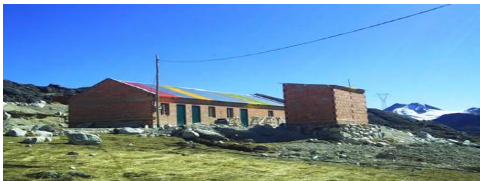
Fuente: Propia - Vista panorámica del refugio en construcción ubicado a 4.650 msnm.
