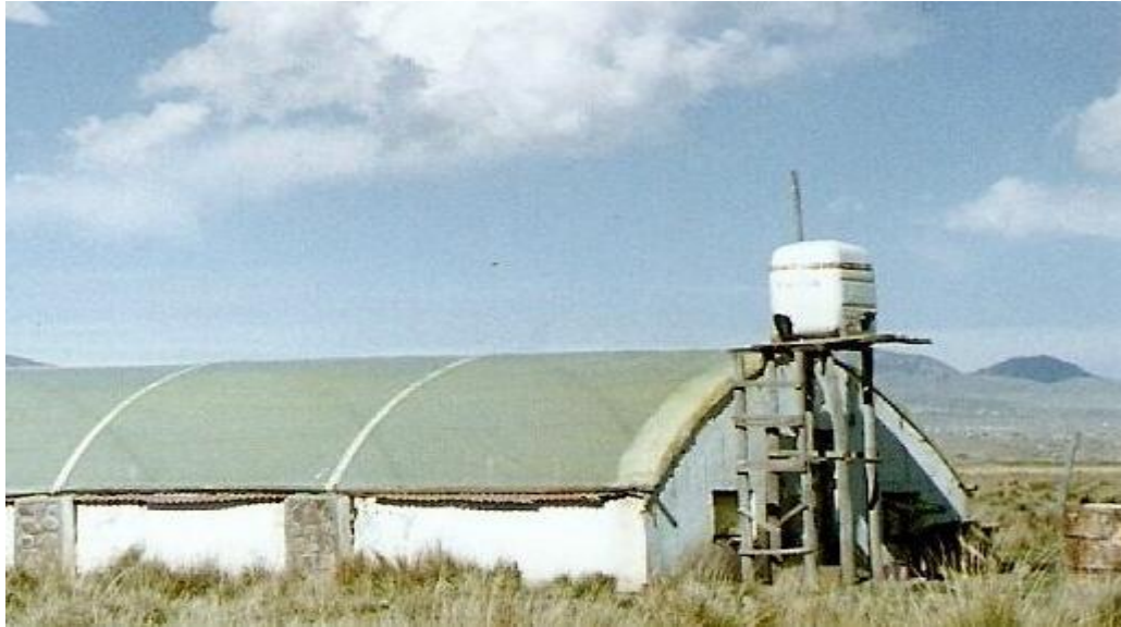
Figura 2. Tanque de 250 litros para riego.
