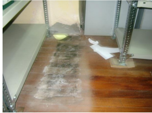
Deterioro del machimbre a causa de la humedad y falta de mantenimiento
