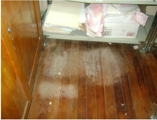
Deterioro del machimbre a causa de la humedad y falta de mantenimiento
