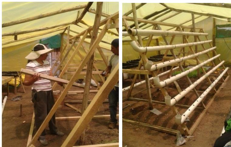
**FIGURA 9.** Armado del sistema en tubo PVC
