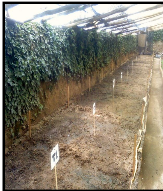
Anexo 10. Colocado de malla milimétrica
