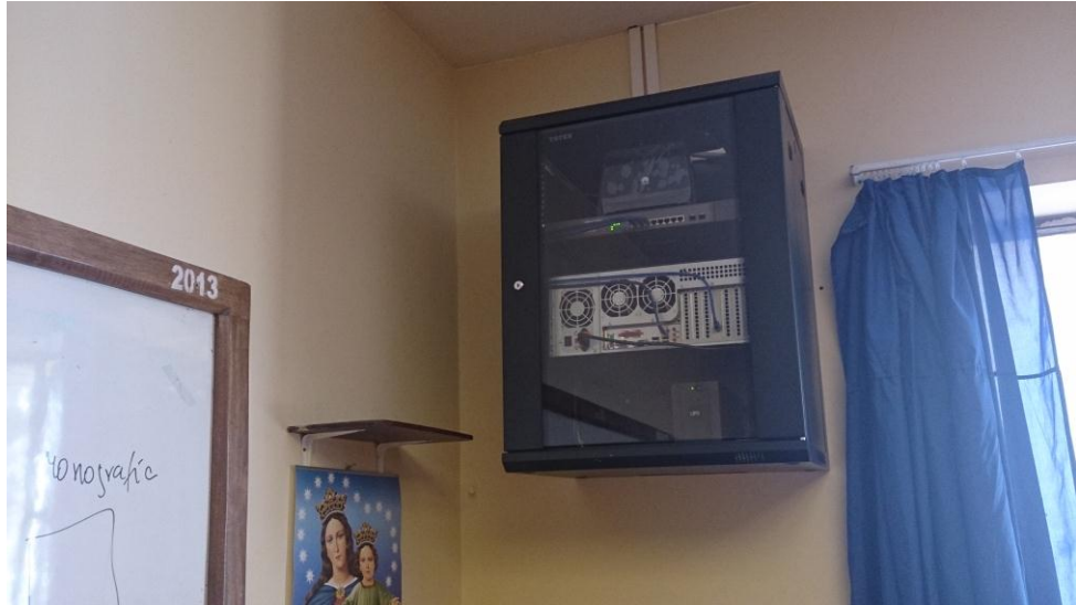
Anexo 17. Servidor y router wifi en la sala de sexto de secundaria, parte del piso tecnológico de Quipus
