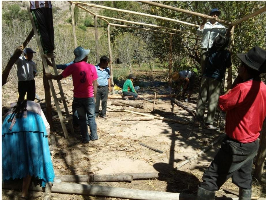
Figura 3. Colocado de la estructura del techo.
