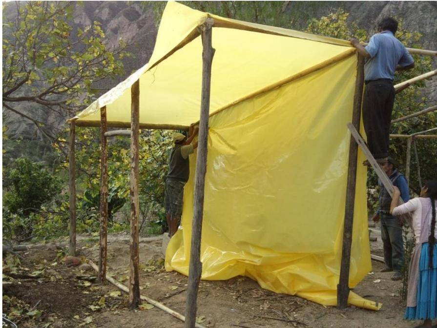
Figura 4. Colocado del Agroflim a la estructura principal
