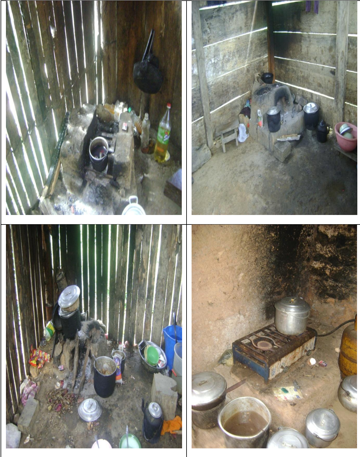
Figura 10. Cocinas Mejoradas Malenas Destruidas
