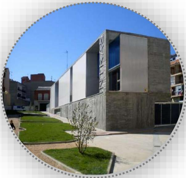
Se disponen en sistemas constructivos de “baja tecnología” que permiten desarrollar una estrategia medioambiental pasiva de alto rendimiento energético desde principios sencillos como la acumulación de calor en muros de gran inercia térmica, ventilaciones de fachadas por filtración en juntas, ventilaciones cruzadas en crujías de dimensiones controladas, etc....
