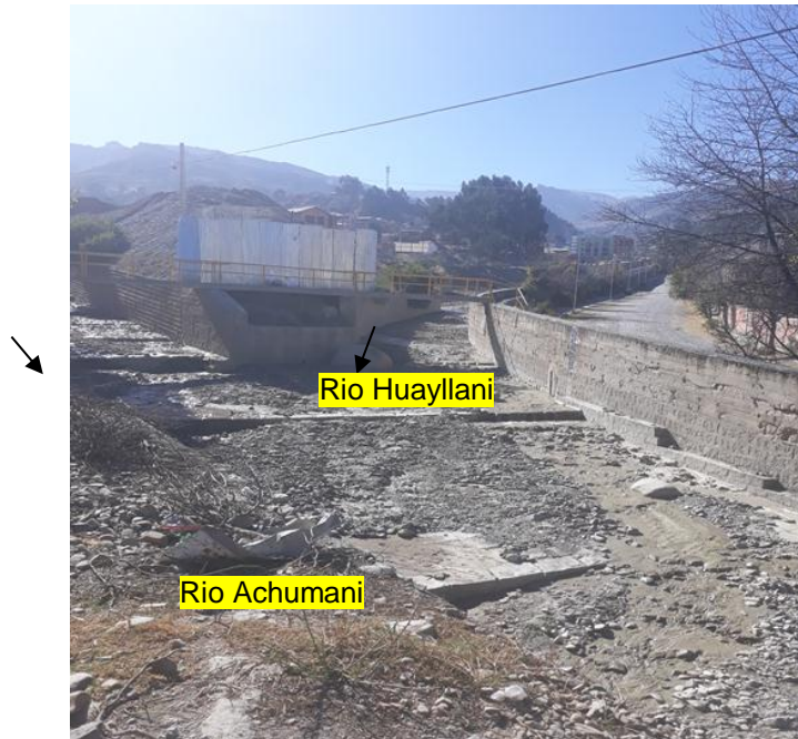
Tramo inicial aguas arriba Progresiva 4+110 Intersección río Achumani – río Kuayllani
