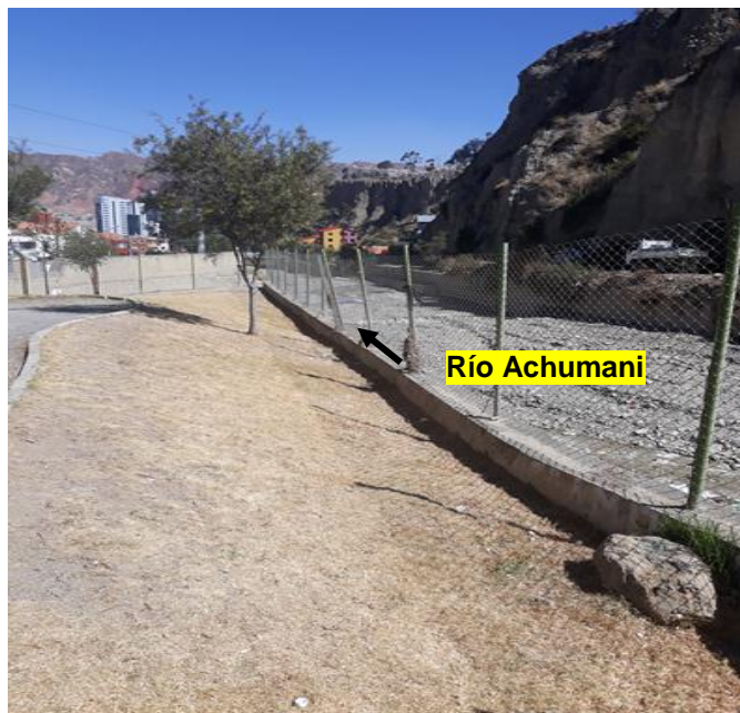
Tramo final aguas abajo Progresiva 0+000 Intersección río Jilusaya - río Achumani Ubicación Calle 5 Achumani y Parque Niños Héroes de Bolivia
