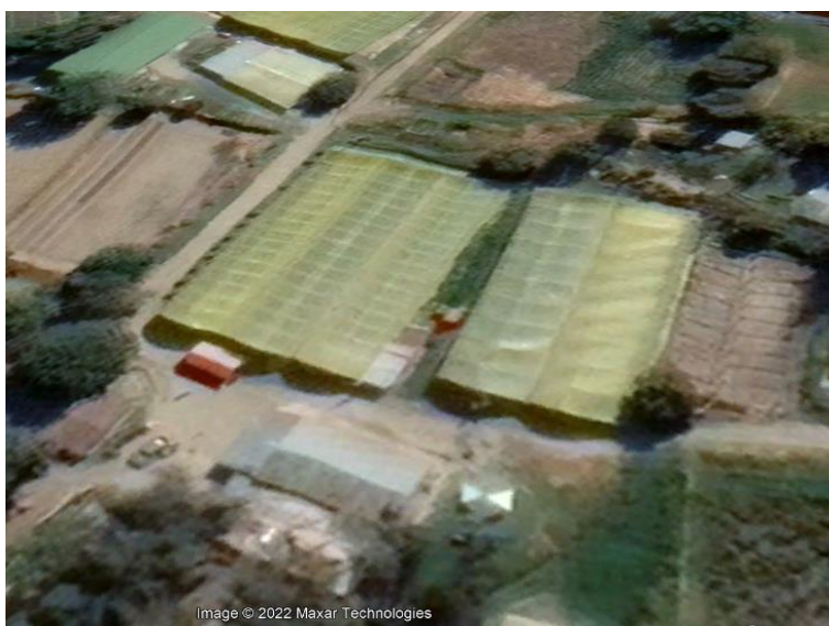
Figura N° 3. Vista satelital del ambiente atemperado
