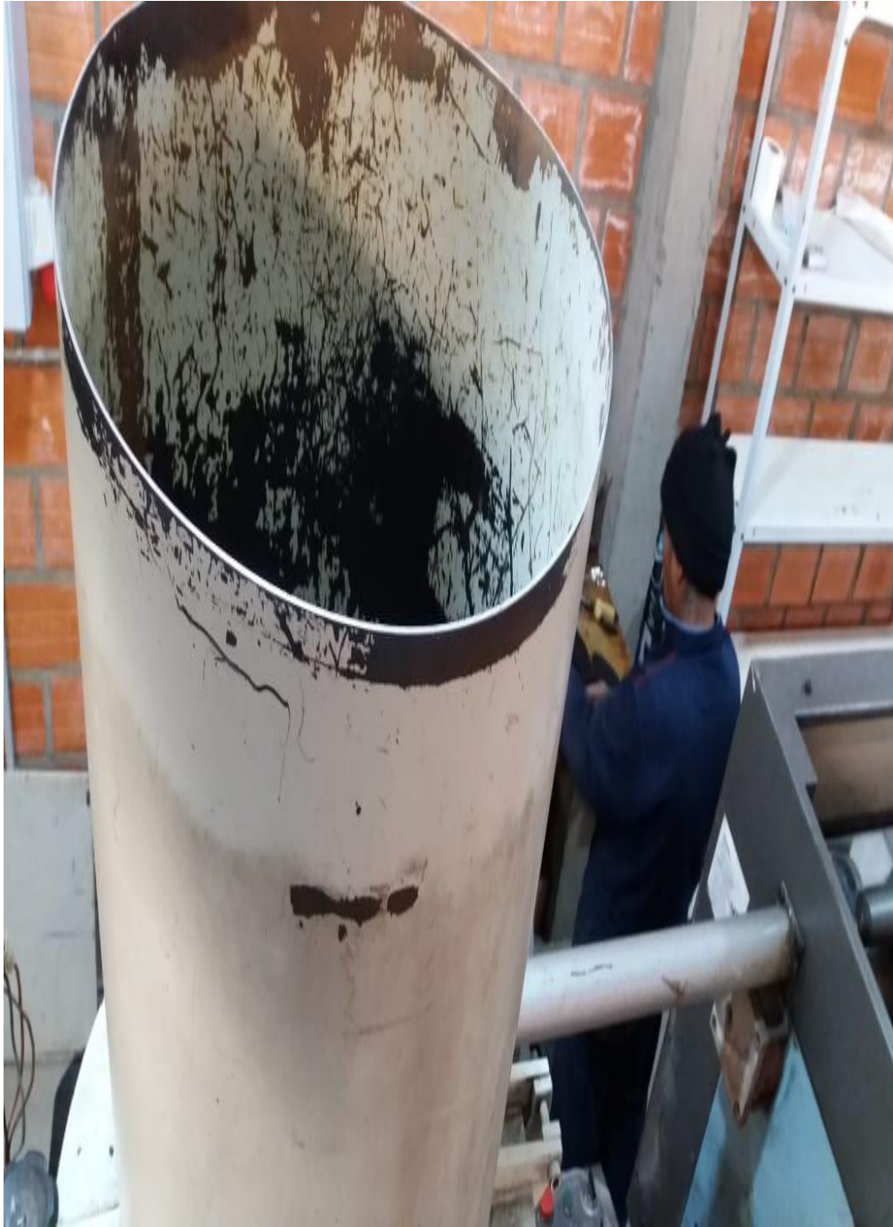
Anexo 4. Contenedor de material para maquina Inyectora de la Empresa ALVAPLAS SRL.
