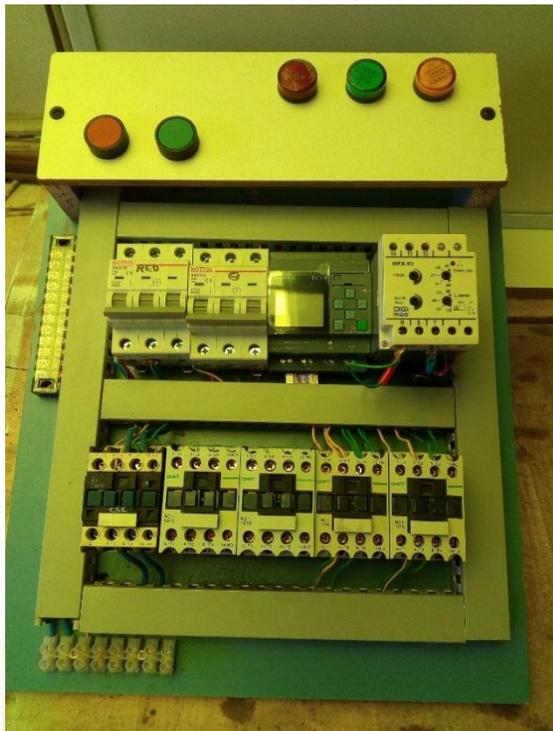
*Figura #38.: Tablero de transferencia.*
