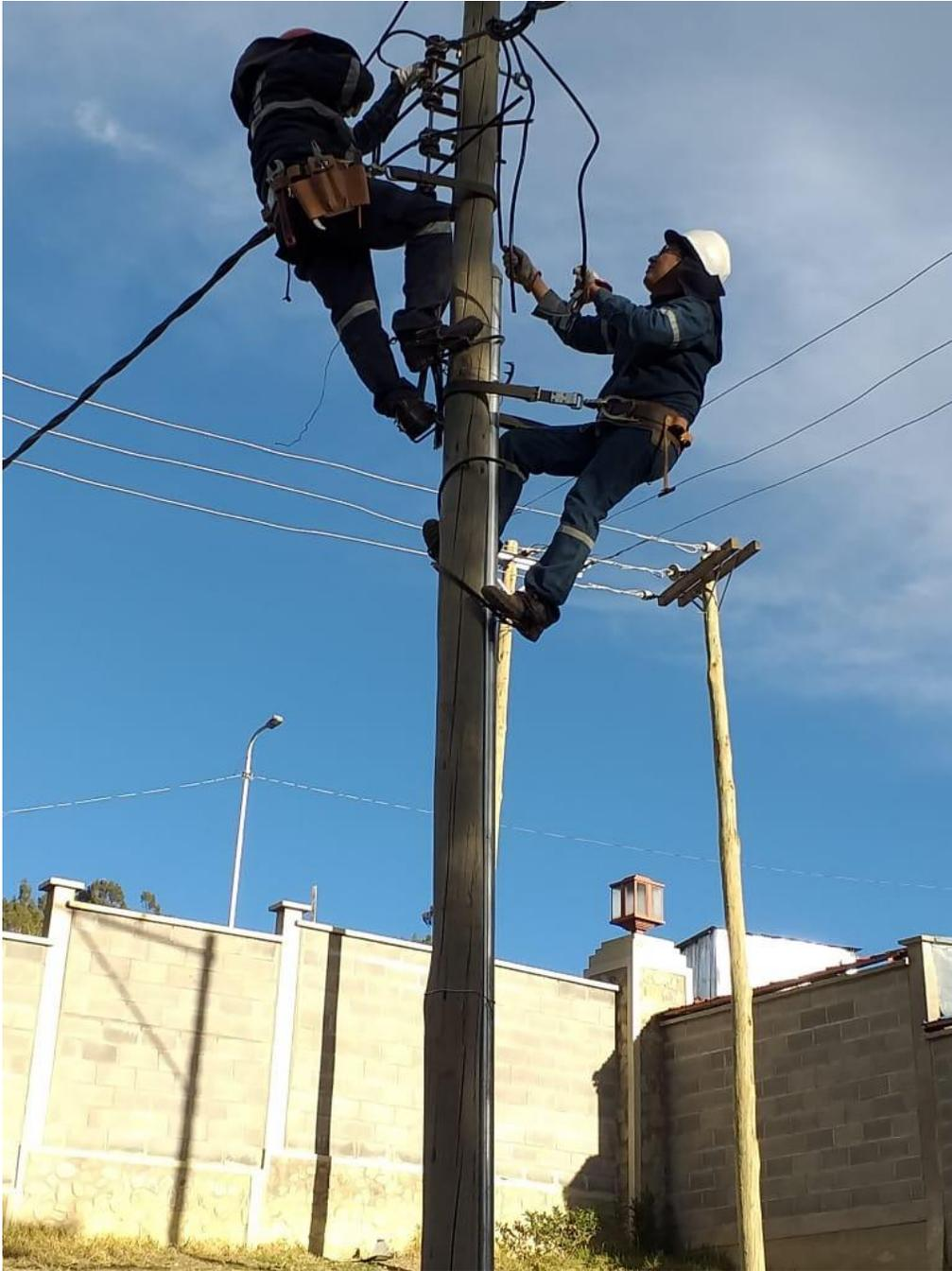
Cableado y conexión de la acometida trifásica a la red eléctrica de baja tensión
