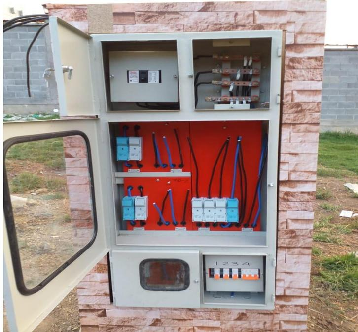
**Figura 11 Montaje del Tablero de Medición**
