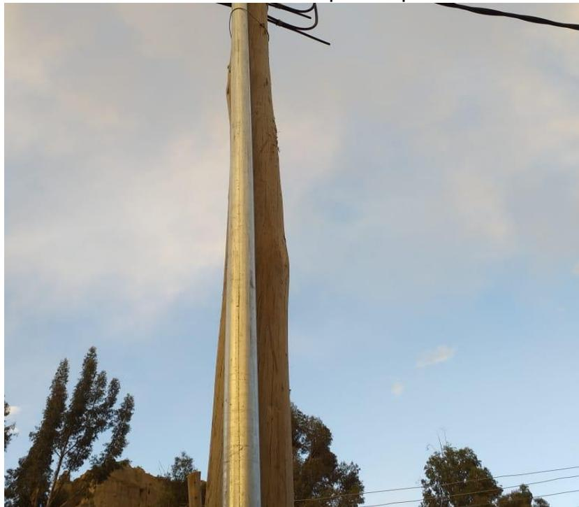
Ducteado de la tubería de hierro galvanizado a 10 cm de la línea de baja tensión
