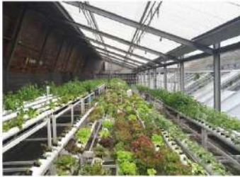
Huertos - invernaderos, estructura alivianada de aluminio y vidrio, cubierta sostenida por tensores.
