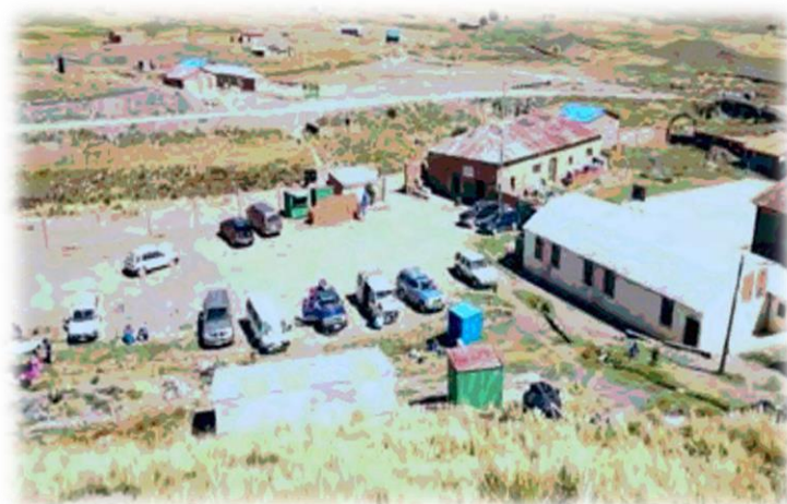
FUENTE: Aguas Termales de Putina, Foto Proyecto Kollan Uma, Fac. Arquitectura UMSA
