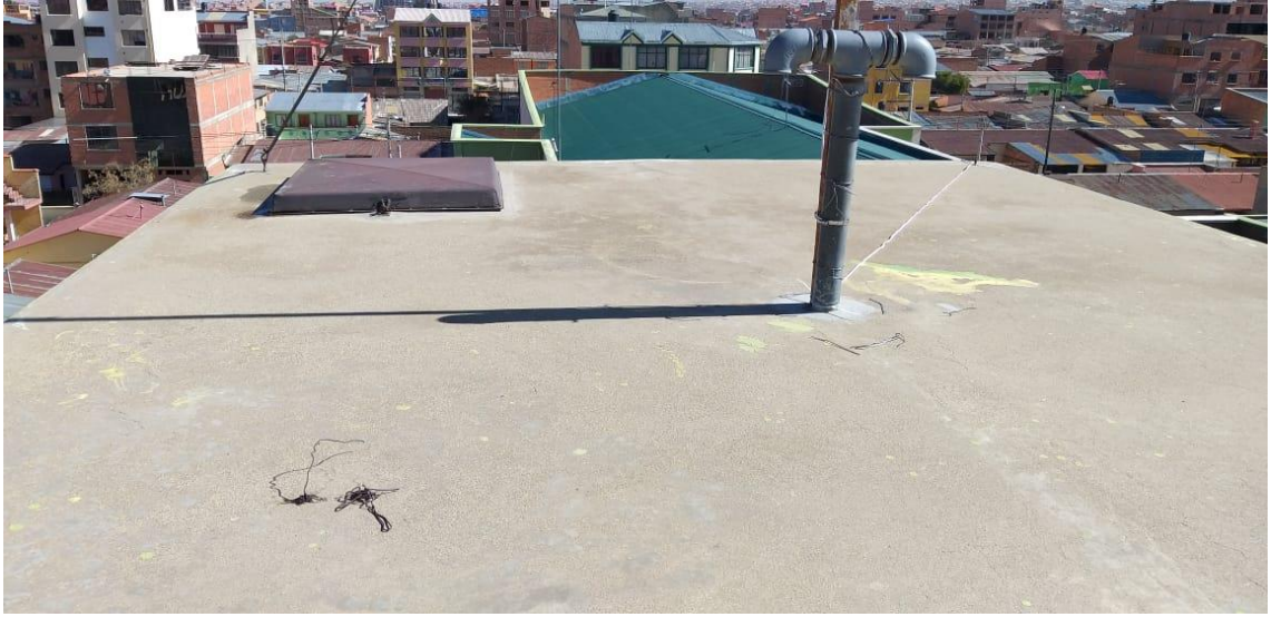
VISTA DE LA TAPA DEL TANQUE DE AGUA
