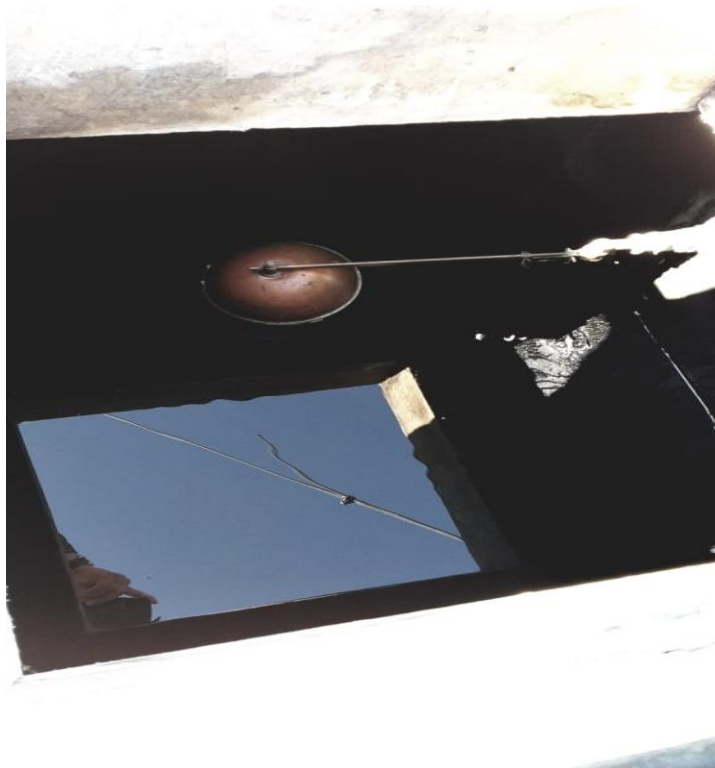
VISTA INTERNA DEL TANQUE
