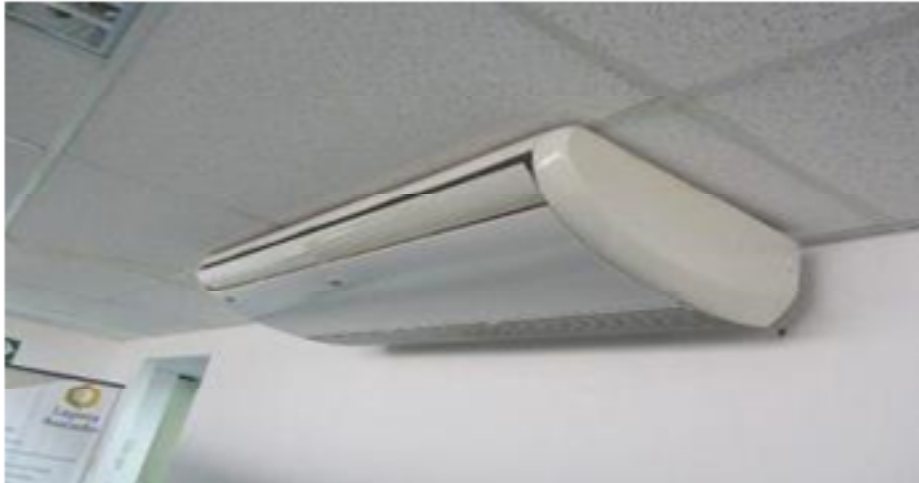
Aire Acondicionado Tipo Split Piso Techo
