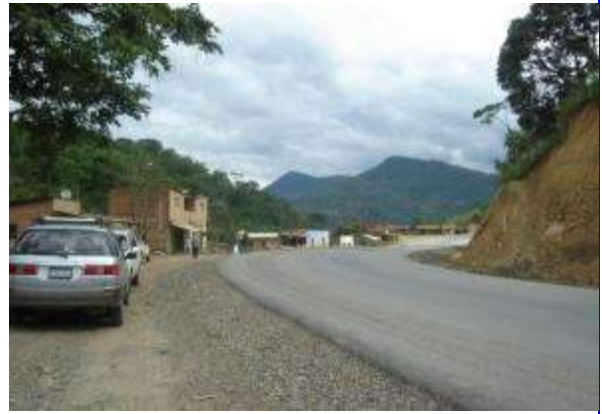
Camino Asfaltado Cantón José Carrasco
